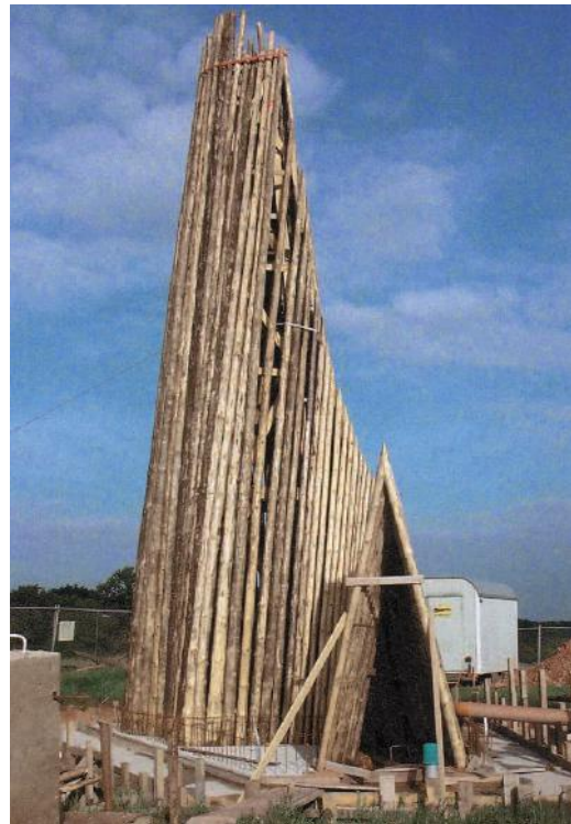
Costruzione della Cappella BRUDER KLAUS , 2007
